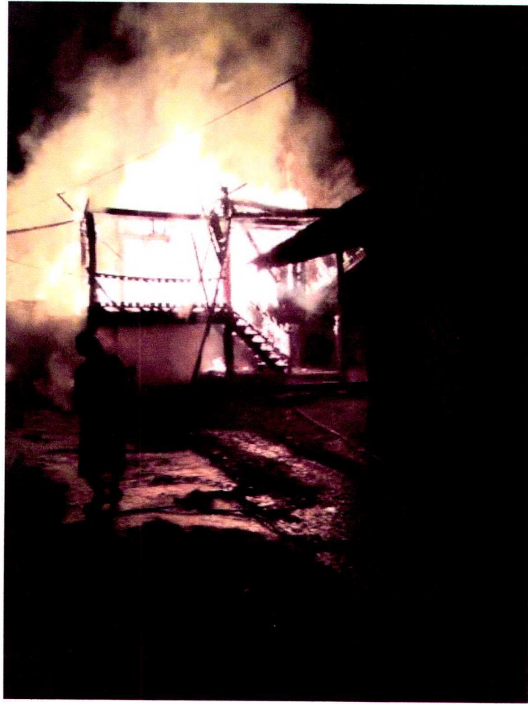
สภาพบ้านหลังจากเกิดเพลิงไหม้
